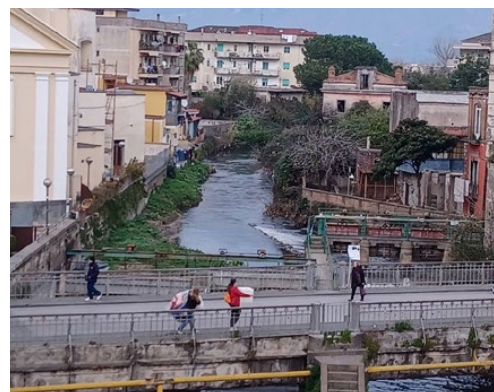
Fig. 2. Ponte sul Fiume Sarno a Scafati (Sa) (foto dell'autore).
