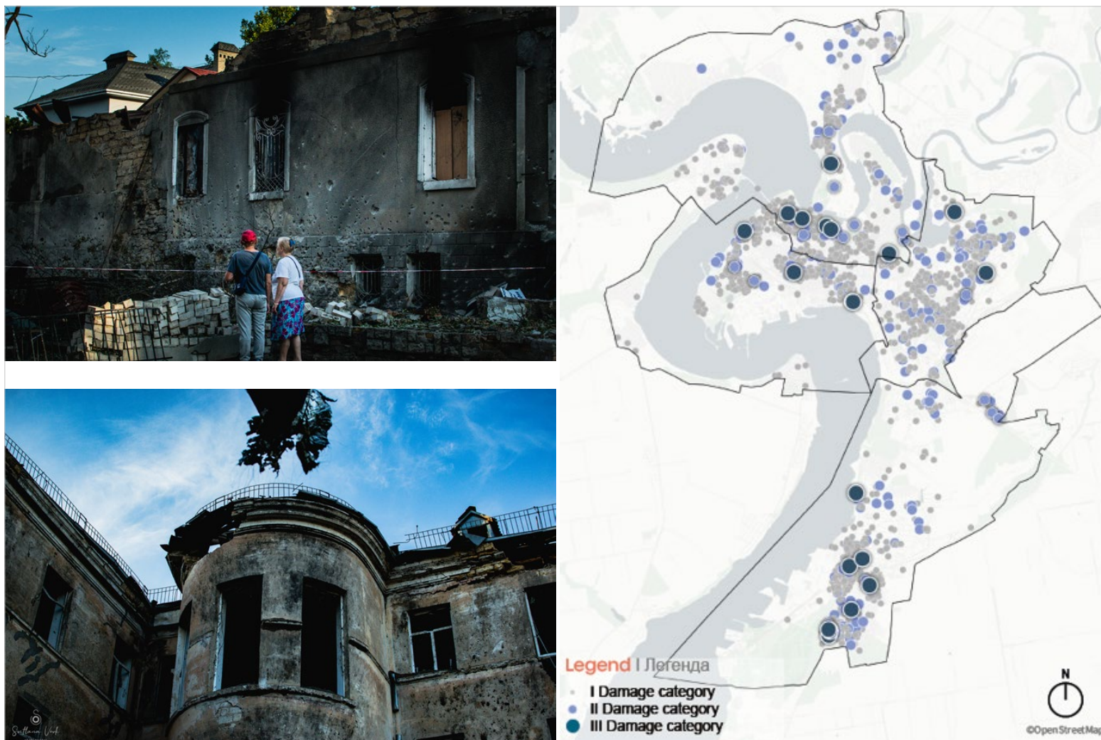
Figg. 4-6. Da sinistra: edificio residenziale ed edificio storico danneggiati (foto di Svitlana Vovk); mappatura dei danni sulla piattaforma municipale GIS (credits: One Works).
