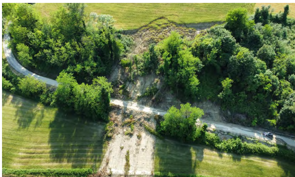
Figg. 5-7. Dall'alto: frana di scivolamento su strato a Montefantini, Comune di Civitella di Romagna; colate di fango a Baccanello, Comune di Predappio; frana di scivolamento rotazionale-colata a Montemaggiore, Comune di Predappio (Foto degli autori).
