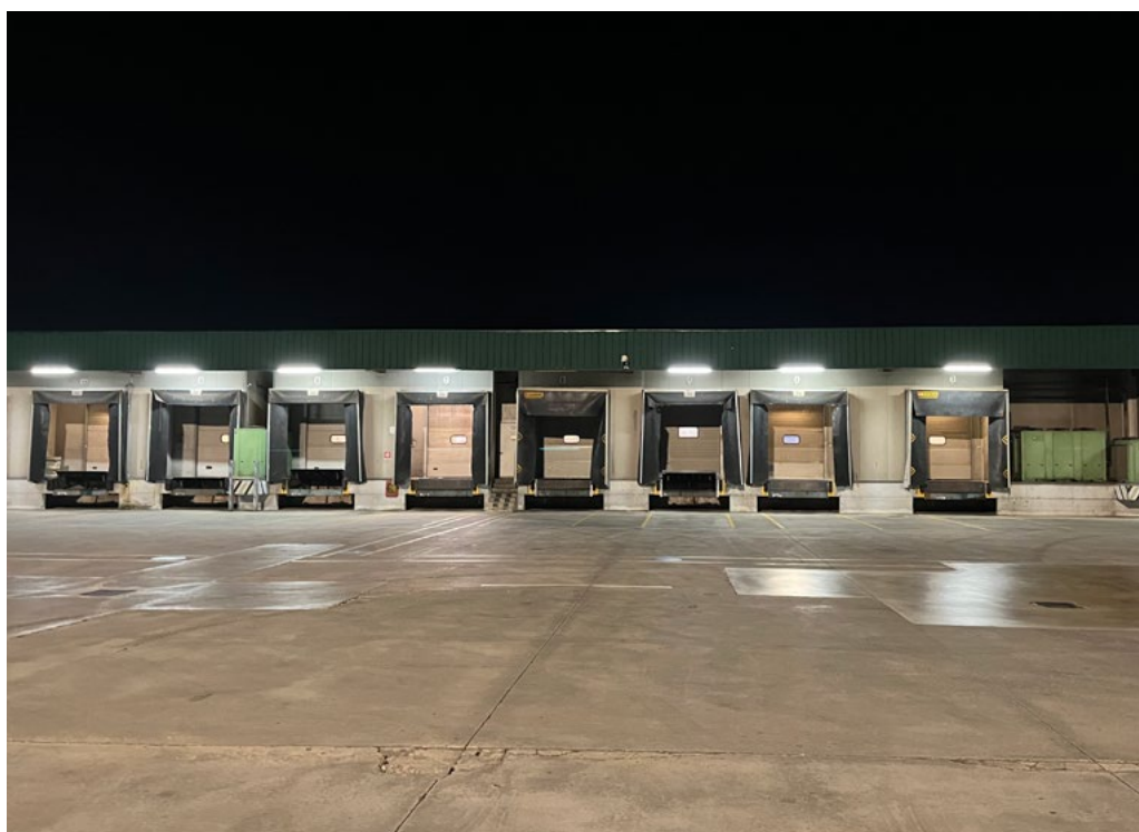
Fig. 1. Centro distributivo Carrefour, Santa Palomba, esterno (foto dell'autore).
