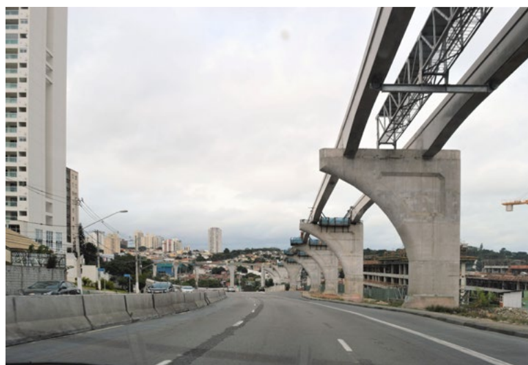
Figg. 5-6. Da sinistra: l'Avenida 23 de Maio, un parkway di attraversamento veloce del centro della città; il viadotto viario Luís Eduardo Magalhães, parte della superstrada nord-sud che attraversa San Paolo e, a fianco e sul fondo, in sopraelevata la monorotaia ad alta capacità in costruzione (foto dell'autore).
