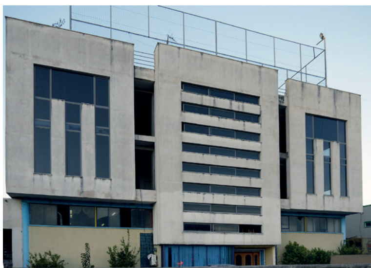
Un omaggio al brutalismo. Invece di cemento grezzo, la facciata è in stucco, che copre una muratura non portante.
