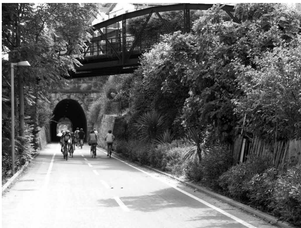
Dettaglio della ferrovia dismessa divenuta ciclabile
