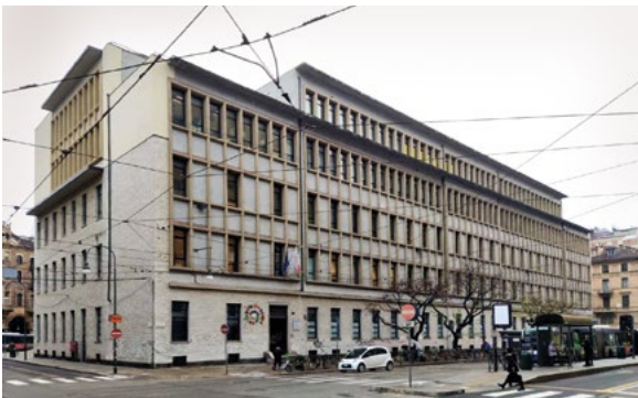
Fig. 3. Ex scuola elementare Pacchiotti ora convitto nazionale Umberto I (via Bertola 10), come da progetto di rinnovamento del comprensorio esistente ad opera degli uffici comunali e sotto la direzione dell'ing. Daprà, dopo i danni subiti dalla struttura a causa dei bombardamenti del 1943 (foto dell'autrice, 2022).
