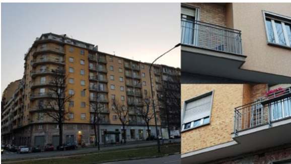
Fig. 3. Edificio residenziale multipiano, corso Maroncelli, angolo via Canelli, progetto dell'ing. Emilio Clara e costruito tra il 1954 e il 1957, inserito nell'attuale contesto urbano e con dettagli dello stato di conservazione degli strati di finitura che hanno visto una progressiva sostituzione non coerente (foto dell'autrice, 2022).
