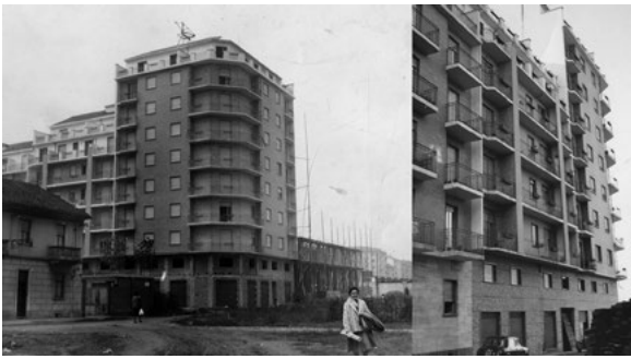
Fig. 2. Fotografie storiche dell'edificio residenziale multipiano in corso Maroncelli nelle fasi conclusive del cantiere. Si nota la realizzazione completata del corpo angolare e i lavori ancora in corso sulla seconda porzione di edificio (fonte: Politecnico di Torino, Dist, APRI-Archivi professionali e della ricerca, fondo ing. Emilio Clara).
