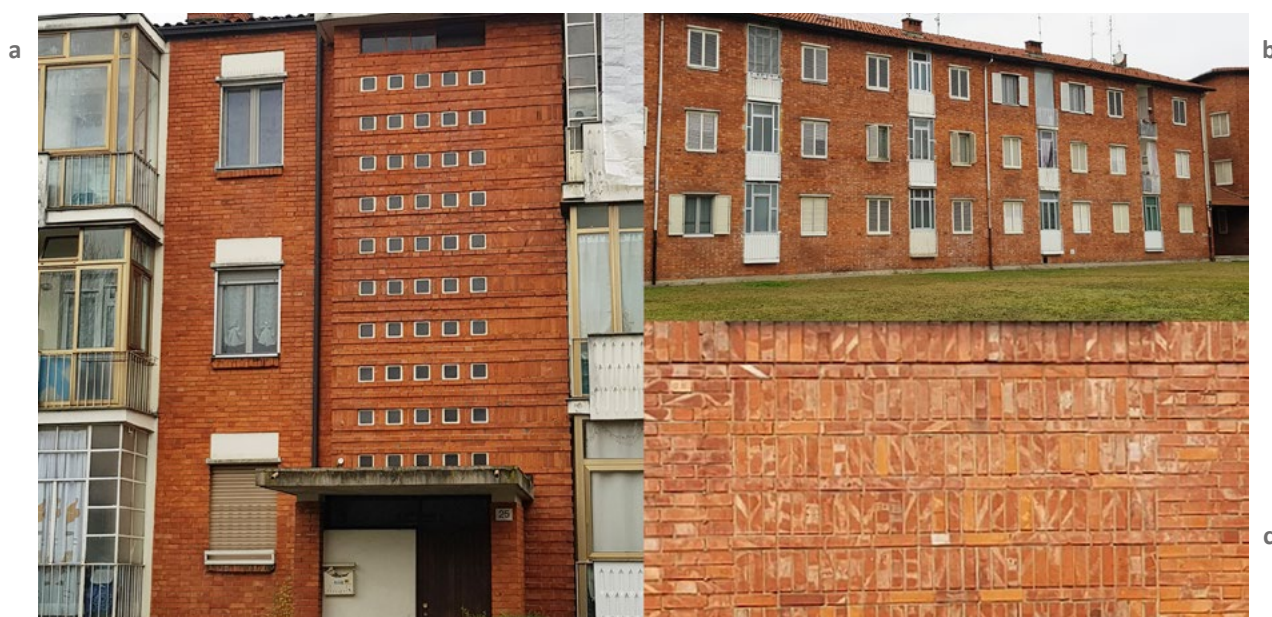
Fig. 4. Da sinistra: a) dettaglio dell'ingresso del blocco 32 progettato da Gino Becker e Gian Franco Fasana nell'attuale stato di conservazione in cui si nota l'utilizzo di elementi in getto di graniglia come parapetti e architravi, di moduli in vetro cemento e di muratura faccia a vista, a cui nel tempo si sono progressivamente sovrapposte numerose superfetazioni; b) vista del prospetto affacciato sugli spazi verdi del blocco 21 progettato da Nello Renacco; c) dettaglio della trama della tessitura muraria del prospetto relativo al blocco 13 progettato da Mario Passanti (foto delle autrici).
