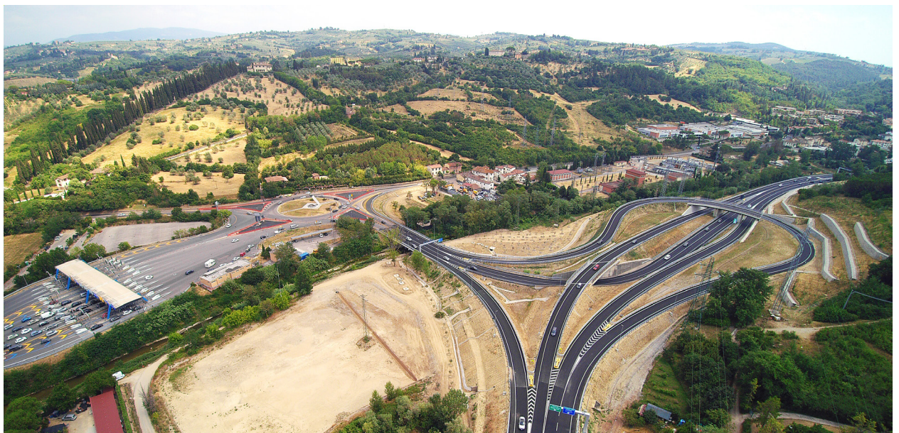
L'innesto, inaugurato nel maggio 2017, tra l'A1, il raccordo autostradale Firenze-Siena e il nuovo bypass del Galluzzo in Comune di Impruneta (foto Lorenzo Pagnini)
