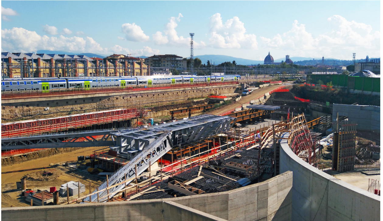
Il cantiere della stazione AV "Belfiore" nell'area degli ex Macelli a Firenze (foto Annalisa Pecoriello)
