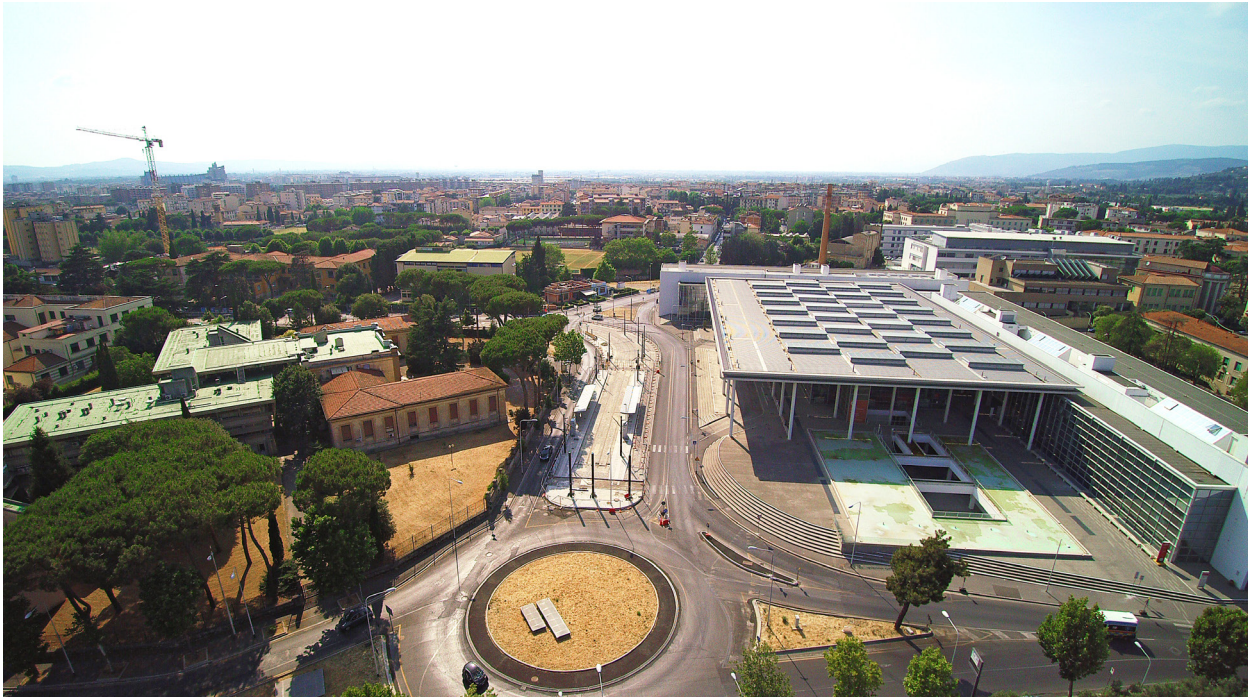
Il capolinea della linea 3 della tramvia presso il policlinico di Careggi a Firenze in via di completamento (foto Lorenzo Pagnini)
