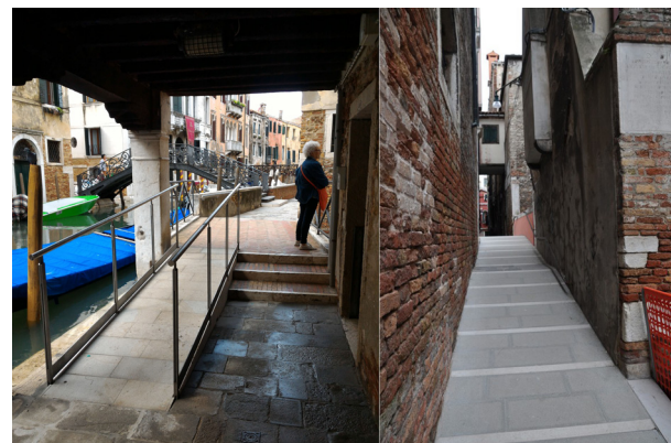
Microinterventi, ponte Benedetti (sx) e ponte Raspi (dx)
