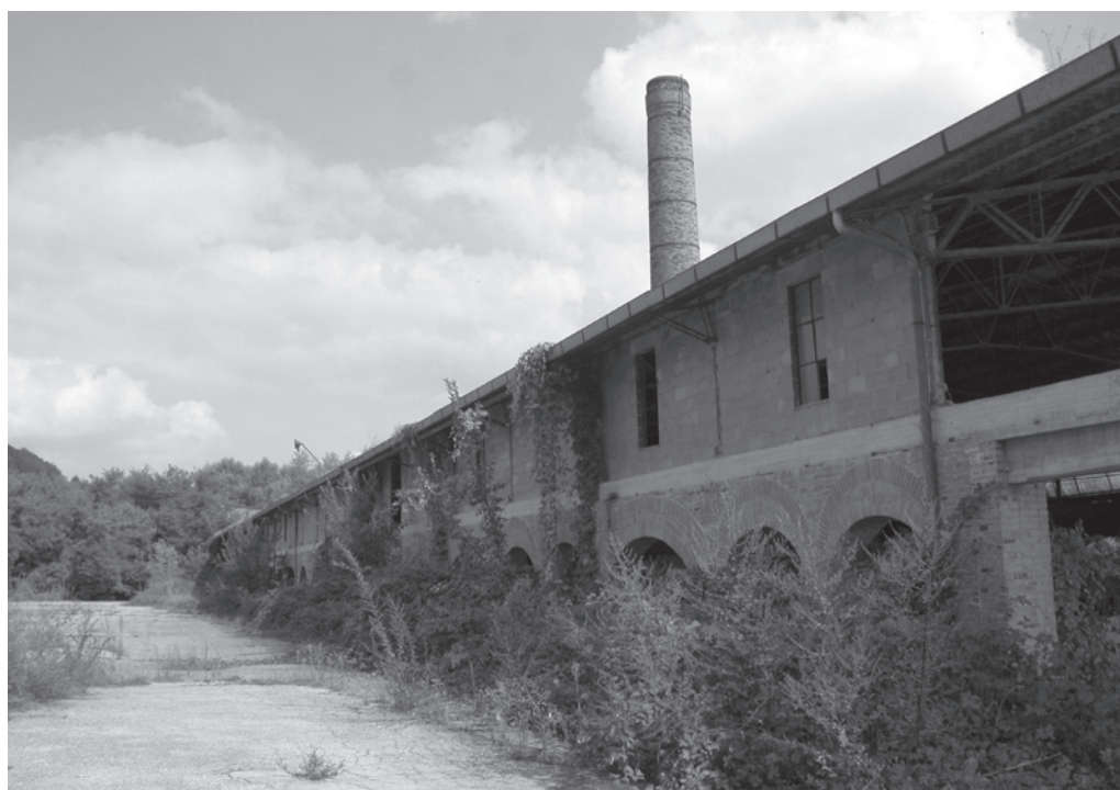
Capannoni della Fornace di Hoffman
