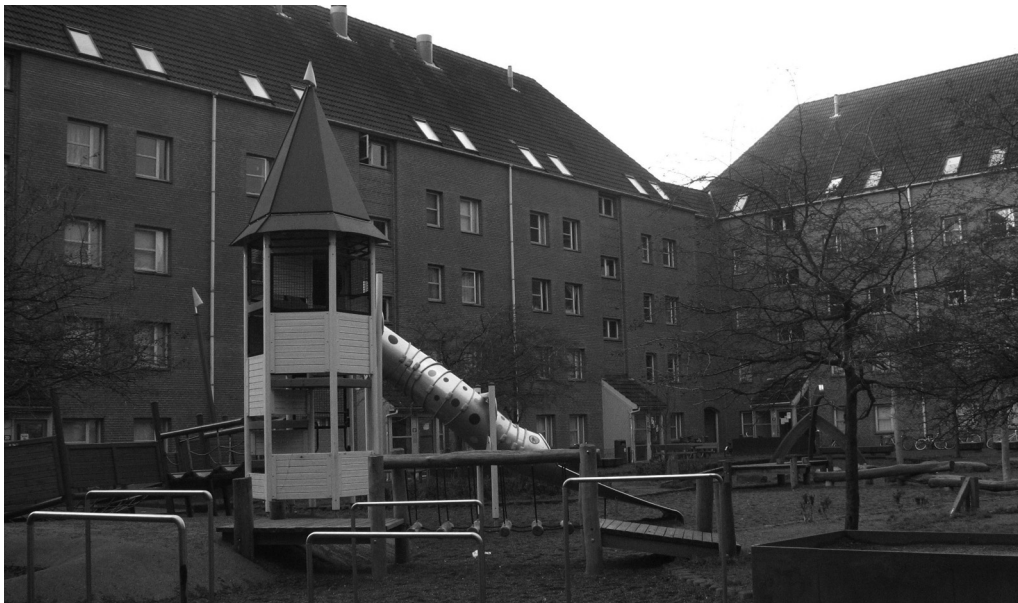
Dettaglio di cortile interno in Mjølnerparken
