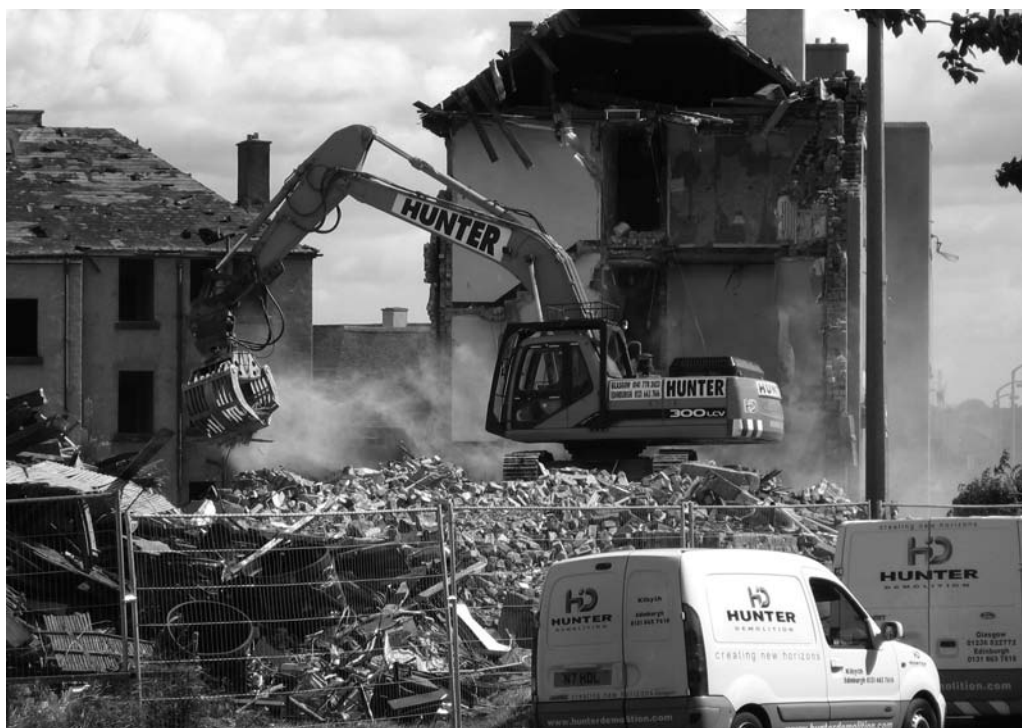
Opera di demolizione a Craigmillar secondo la nuova strategia PARC
