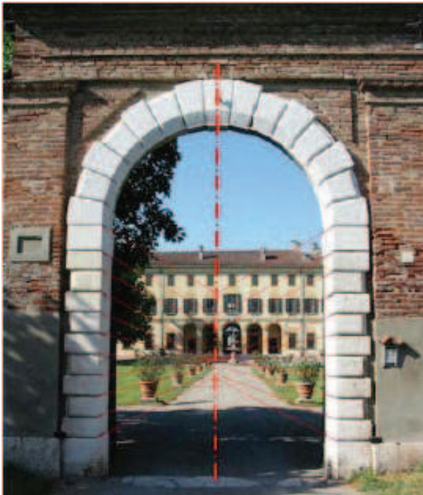
▲ Portale prospettico di palazzo Negroboni Feltrinelli, Gerolanuova (Bs) con evidenziazione dell'andamento prospettico delle bugne, convergenti sull'asse di simmetria secondo una strutturazione a spina di pesce di memoria romana (Foto e rielab. IP).
